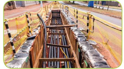
5. ábra - Föld alatti áramvezeték
